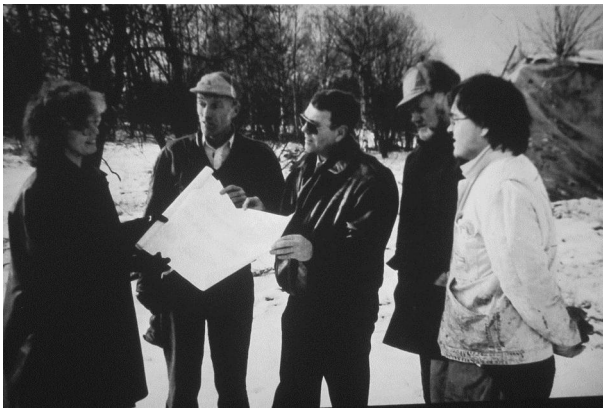
Planering inför restaurering av ringugnen vid Gunnarps tegelbruk
